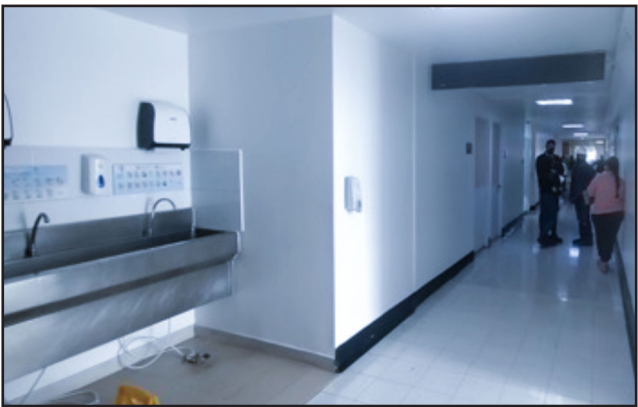
Figura 74. Adecuación de infraestructura servicio pretrasfusional
